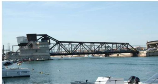
Pont Sadi Carnot (Sète)
